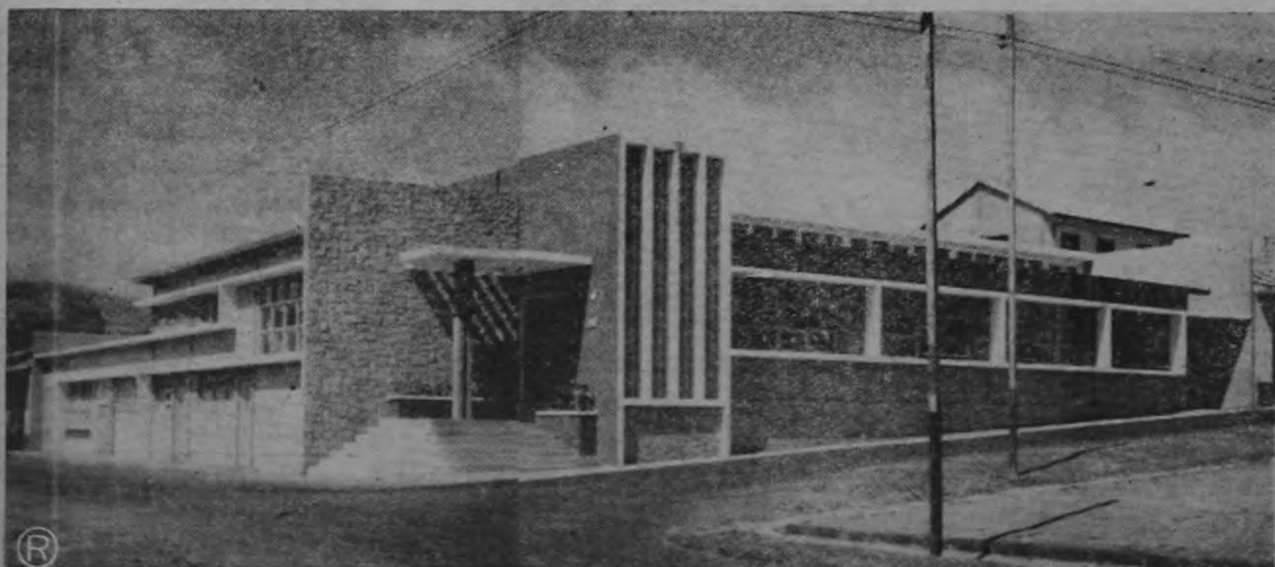
MOP CONSTRUYE PALACIOS MUNICIPALES.— PALACIO MUNICIPAL DE SANTO DOMINGO DE HEREDIA.— Construido dentro del plan de ayuda, elaborado por las Municipalidades y el MOP; este edificio consta de dos plantas, con una superficie total de 350 metros. La planta baja tiene, 350 metros en construcción, distribuidos en la forma siguiente: Vestibulo e Información, Telégrafos y Correos, Alcaldía, Servicios Sanitarios Públicos, Tesorería y Contaduría, Inspección Sanitaria, Jefatura Política, Dormitorios para Guardias, dos Calabozos, y Garage. La planta alta tiene, 200 metros en construcción, distribuidos en: Vestibulo Salón de sesiones Municipales, Salón para Filarmonía, Servicios Sanitarios y un Salón para futuras oficinas.
